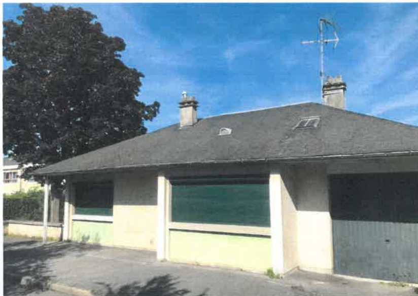
Ancien logement de fonction, depuis l'avenue de Beauval
